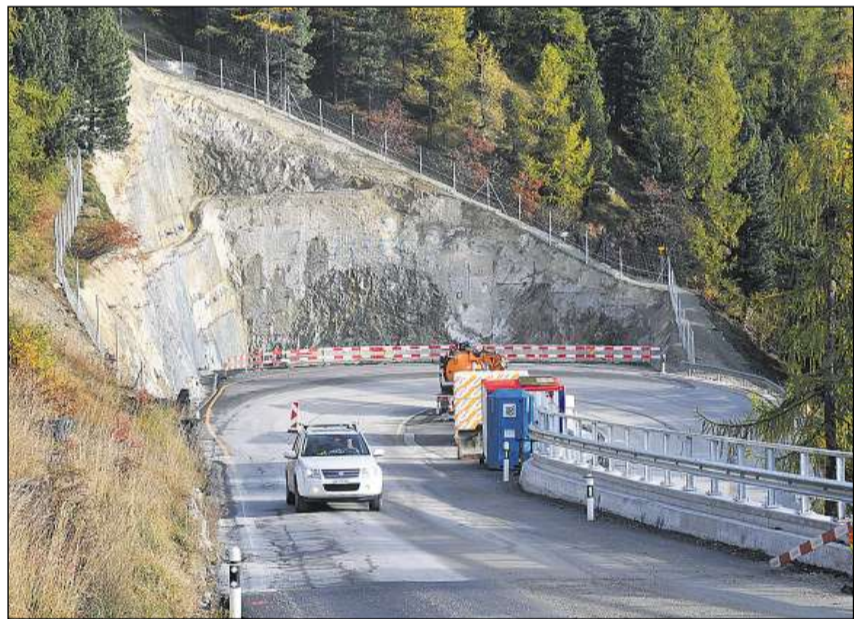
Qua es previs il portal sura dal tunnel.
