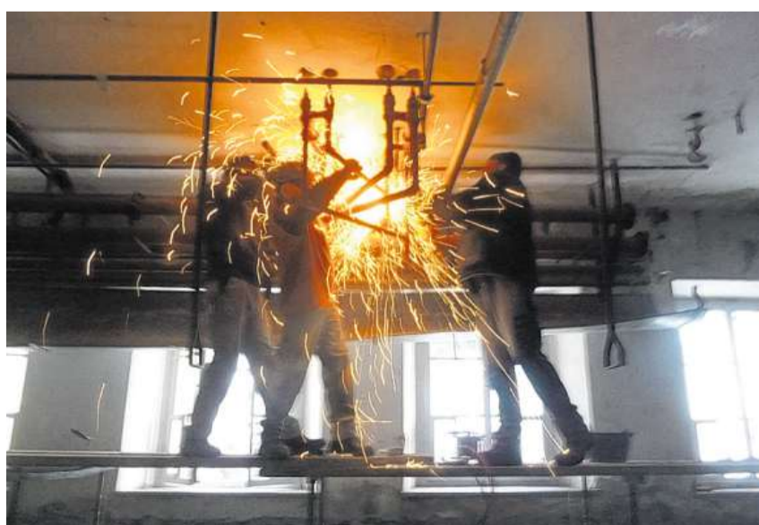
Auf dass die Funken sprühen: Die Baustelle im Kulturzentrum Nairs wird beim Sommerfest zum Dreh- und Angelpunkt von Kunstaktionen. Pressebild
