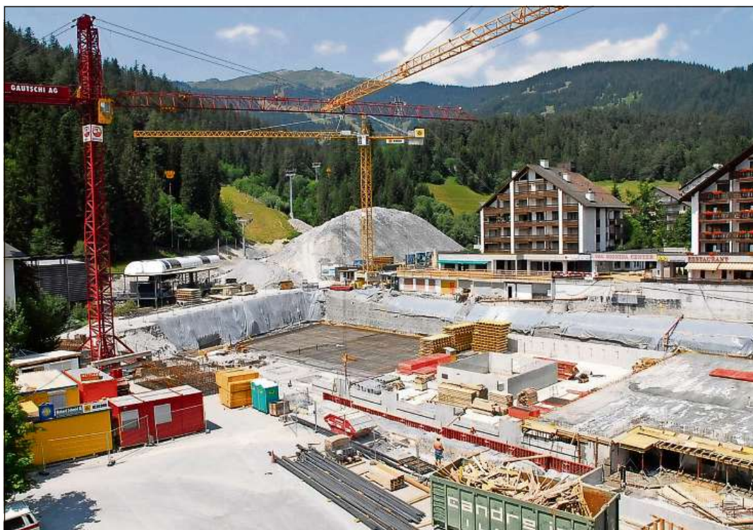
Ils piazzals da baghegiar sereduceschan. Cheu quel dils Rocksresort a Laax Murschetg nua ch'ins ha construiu letgs caulds. FOTO A. BEELI
