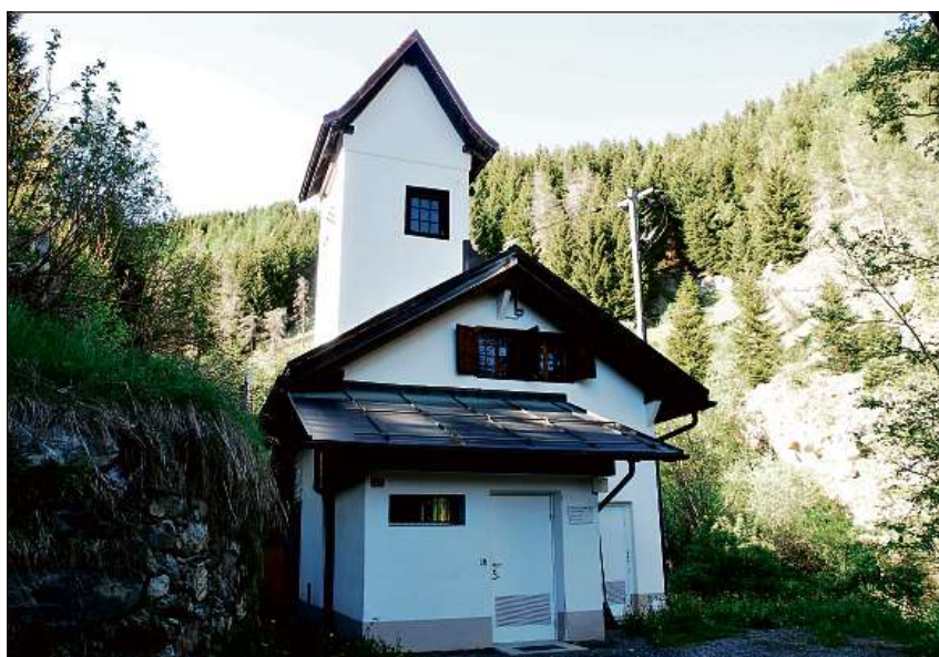
Il cudisch culla historia dall'Ovra electrica Lumbrin presenta era la casa da maschinas ella Val Mulin culla tuor ch'is da Lumbrin numnavan «buliu».
