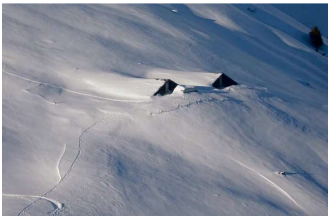
L'alp Lumpegna avon il schaner 2019, cura ch'ina lavina ha destruiu l'infrastructura.
