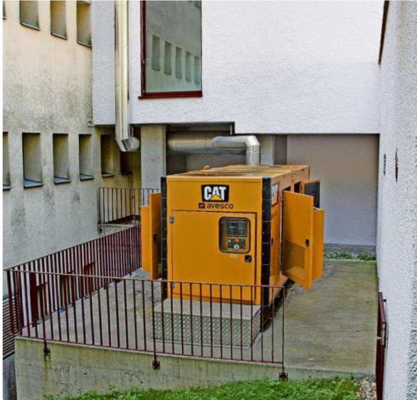
Il generatur cun motor da diesel dil Spital regional Surselva survegn tuttenina dapli muntada. Inaga il meins vegn el mess en funcziun per esser segirs ch'el funcziuneschi el seracass.
