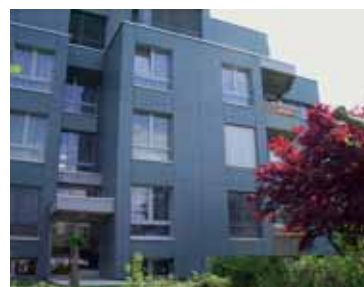
Energetische Gebäudesanierung Mehrfamilienhaus vor und nach der Sanierung.
