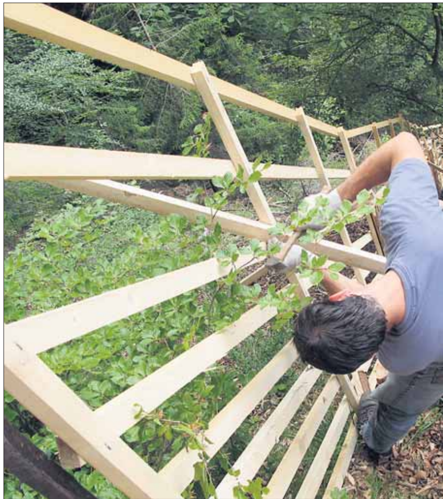
Im steilen Gelände wird klar, weshalb es einen Schutzwald braucht. Bergwald ob Felsberg.
