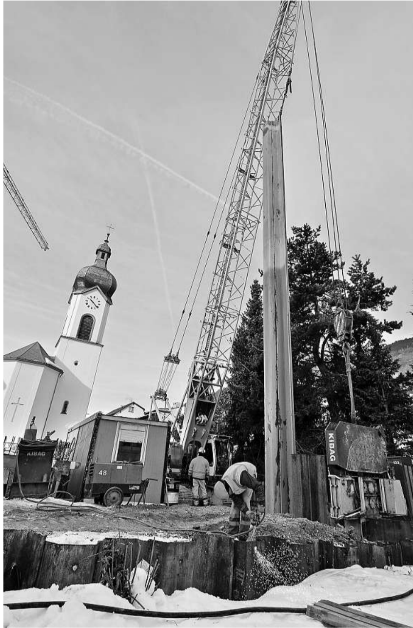
Kranarbeit: Wie derzeit im hinteren Baugelände werden ab Montag auch an der Ilanzer Glennerstrasse Spundwände aus dem Boden geholt. Bild Jano Felice Pajarola
